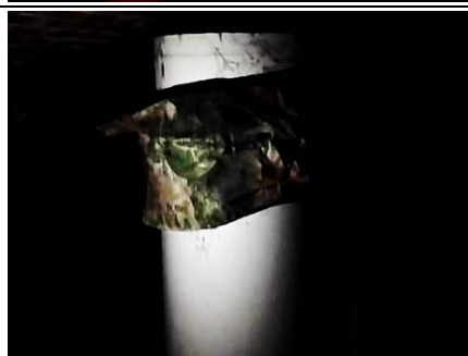
Photo ECS 200 litres electrique Localisation : Sous-Sol - Chaufferie Ouvrage :
