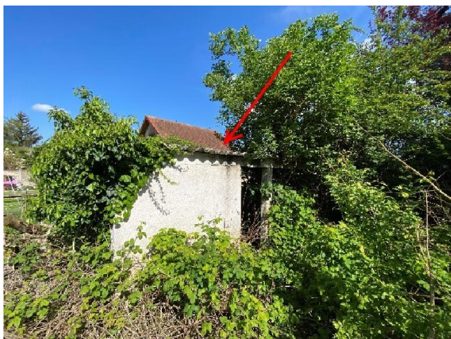
Toiture Poulailler-Appentis Plaques ondulées fibre-ciment.
