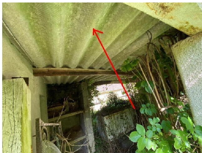
Toiture Poulailler-appentis Détail plaques ondulées en fibre-ciment.
