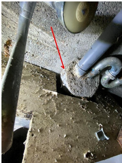
Atelier Au dessus de l'évier Conduit fibre-ciment.
