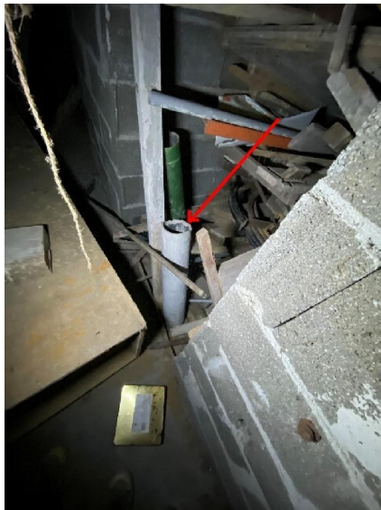
Garage 02 (sous escalier) Conduit fibre-ciment
